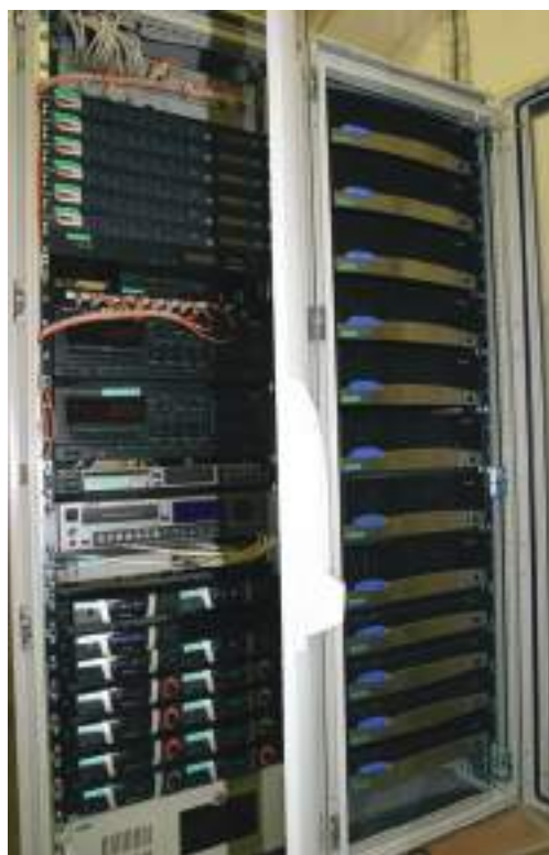
Um dos vários bastidores do sistema de som no qual é possível encontrar amplificadores Crown, processadores BSS Audio e os receptores de microfones sem fios da AKG tudo marcas do Grupo Harman Pro, representadas pela Custódio Cardoso Pereira e instaladas pela Sislnt. É possível ainda verificar nesta sala de controlo e operação a mesa de Mistura Virtual que controla todo o sistema de som no G.E.C.A. em paralelo com um outro computador portátil que se pode localizar em qualquer ponto da audiência nas celebrações
