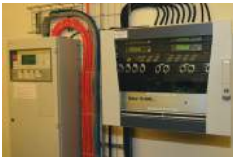
Na sala de gestão centralizada encontram-se a central de incêndio da Siemens à (esq. a ) e o bastidor das comunicações técnicas Telex SC-600
