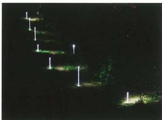
Prumos de luz: Cilindros de acrílico despolido enterrados; iluminação do interior com LEDs Buried acrylic cylinders; inner lighting with LED
